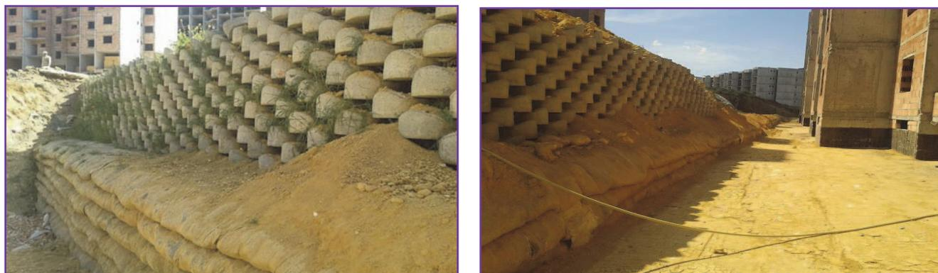
Figure 6. Vues d'ensemble du mur en sol renforcé (partie enterrée et partie hors sol).
