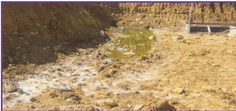
Figure 2. Présence des eaux d'infiltrations.
