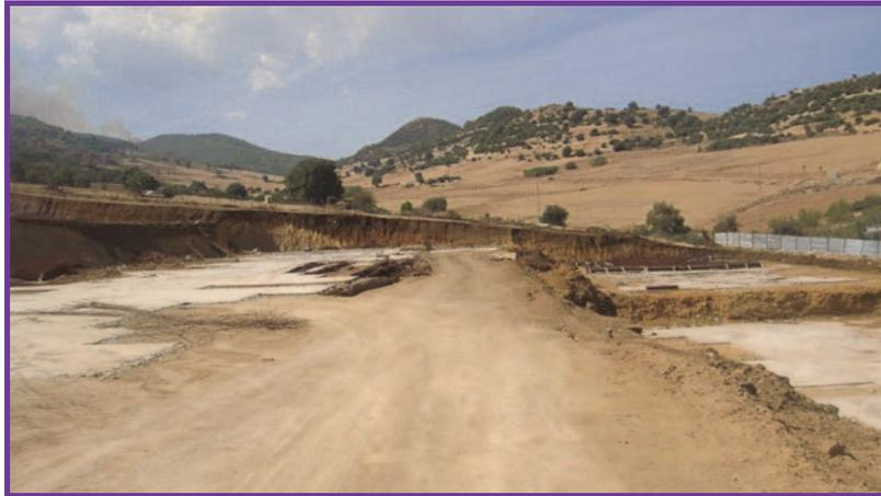
Figure 4. Préparation des fondations des bâtiments.
