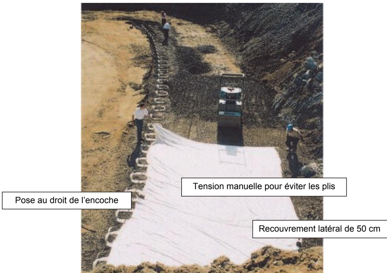
Figure 5. Mise en place des nappes géotextiles.
